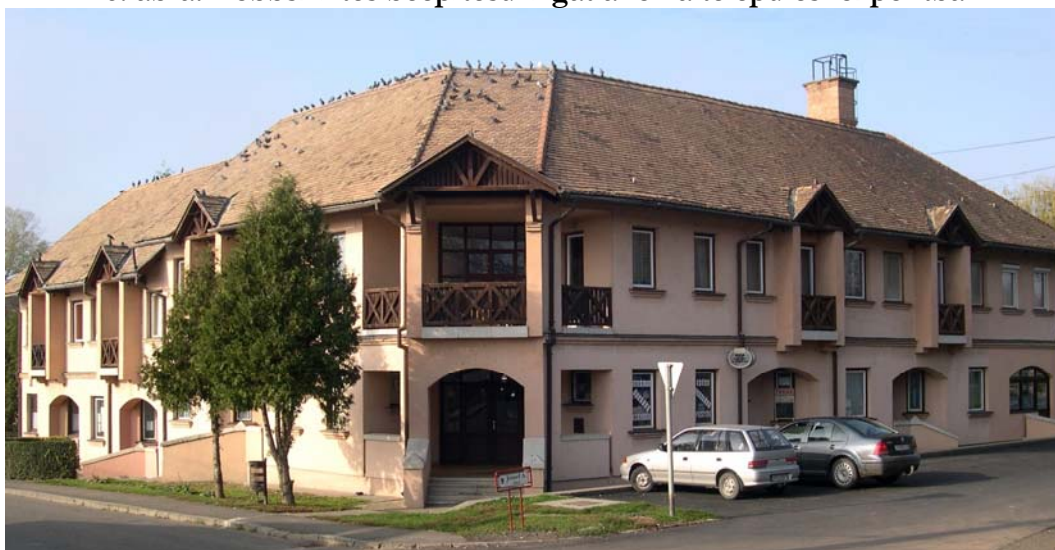
26. ábra: Többszintes beépítésű ingatlanok a településközpontban
