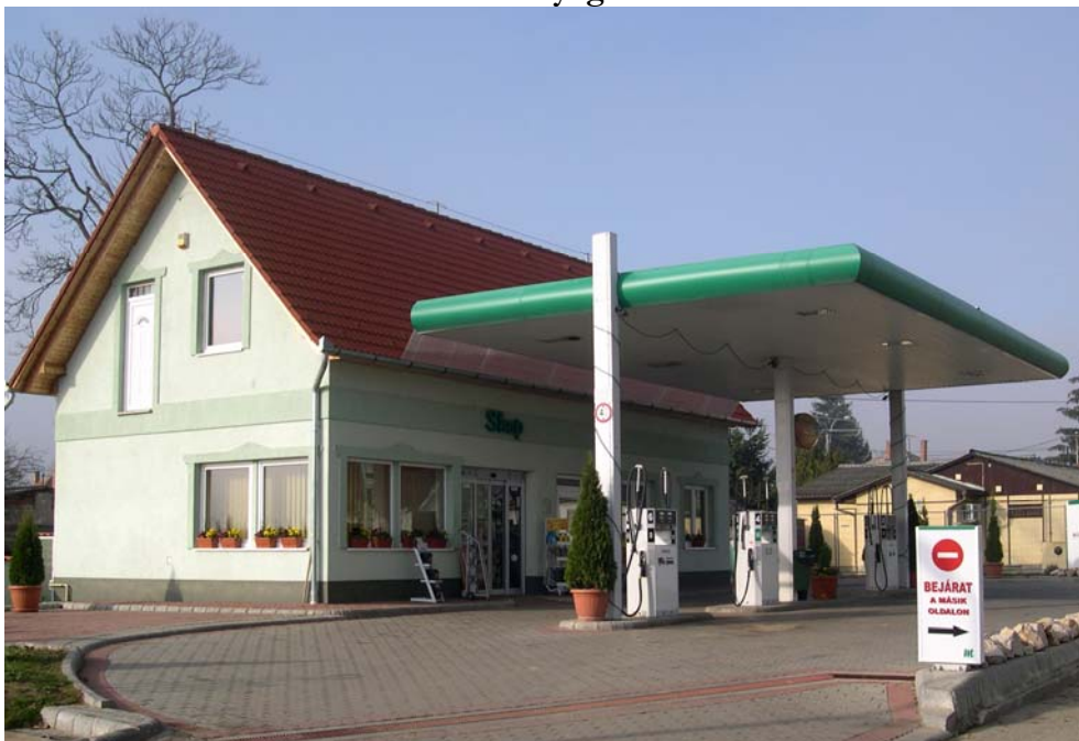
16. ábra: Üzemanyagtöltő állomás
